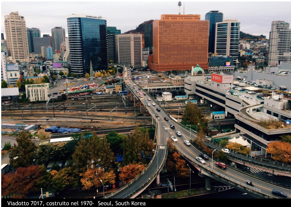
Viadotto 7017, costruito nel 1970- Seoul, South Korea
